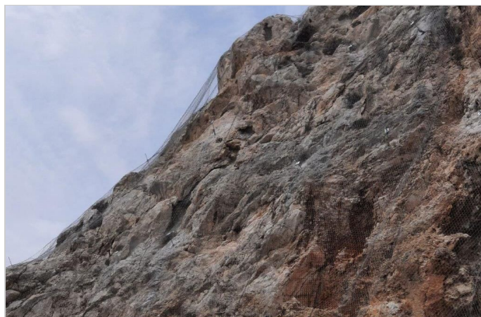
ΕΠΕΝΔΥΣΗ ΠΡΑΝΩΝ ΜΕ ΧΑΛΥΒΔΙΝΟ ΠΛΕΓΜΑ STEELGRID MO-300
