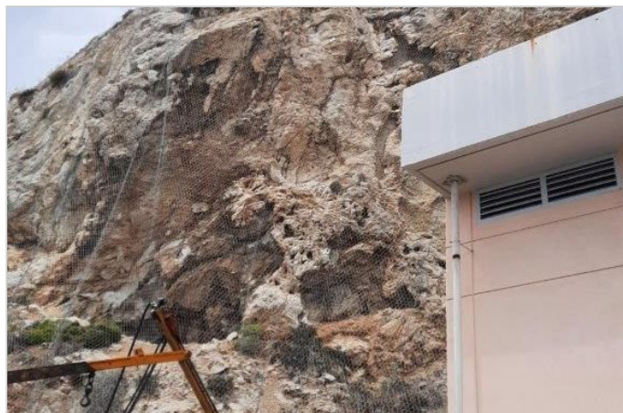
ΕΡΓΑΣΙΕΣ ΤΟΠΟΘΕΤΗΣΗΣ ΠΛΕΓΜΑΤΟΣ STEELGRID MO- 300
