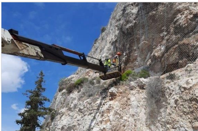
ΕΠΕΝΔΥΣΗ ΠΡΑΝΩΝ ΜΕ ΧΑΛΥΒΔΙΝΟ ΠΛΕΓΜΑ STEELGRID MO-300 ΣΤΗ ΦΑΣΗ ΤΗΣ ΤΟΠΟΘΕΤΗΣΗΣ
