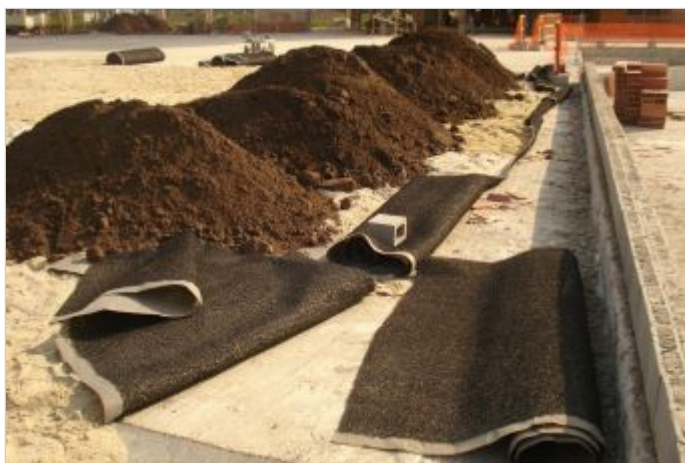
Durante a obra
