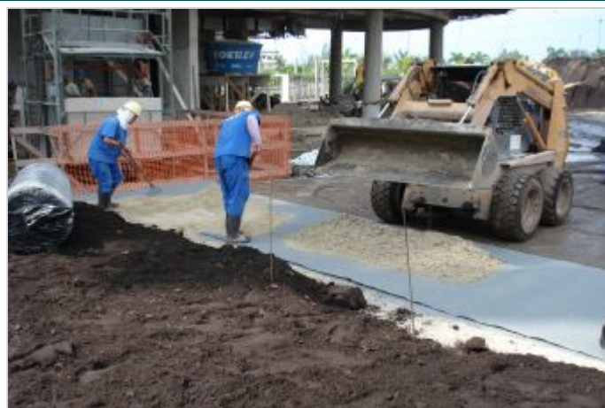
Durante a obra
