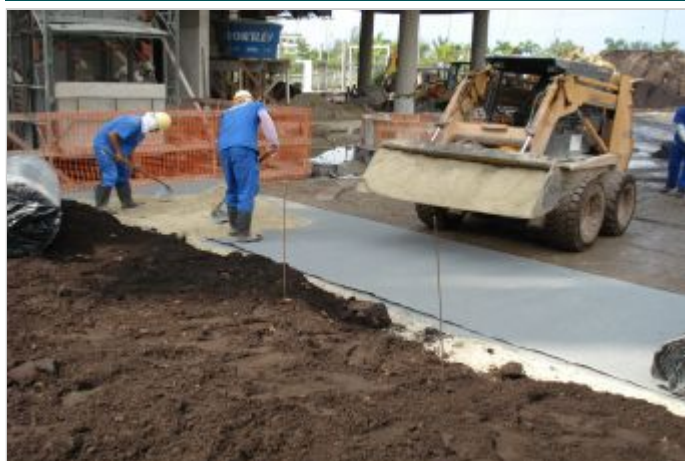
Durante a obra
