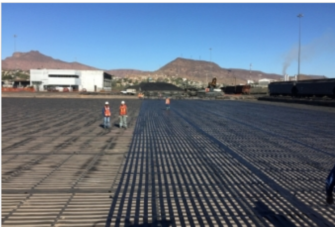
Durante la Obra
