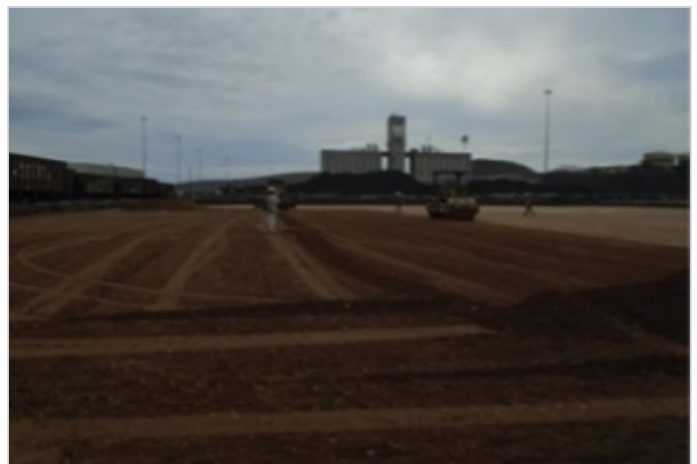
Durante la Obra
