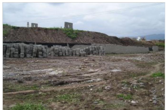
Durante la Obra
