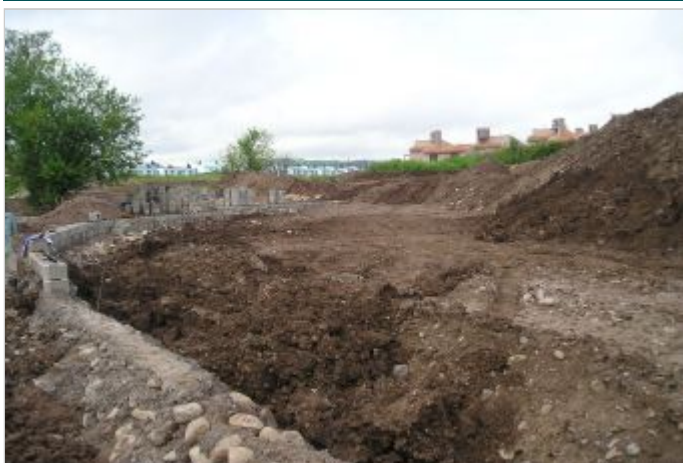
Durante la Obra
