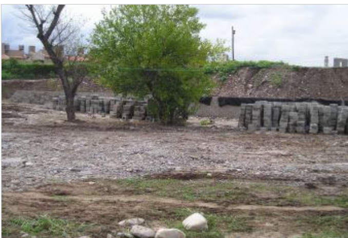
Durante la Obra
