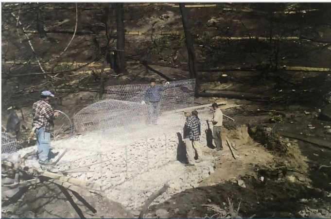
ΣΥΡΜΑΤΟΚΙΒΩΤΙΑ ΣΤΗ ΦΑΣΗ ΤΗΣ ΚΑΤΑΣΚΕΥΗΣ
