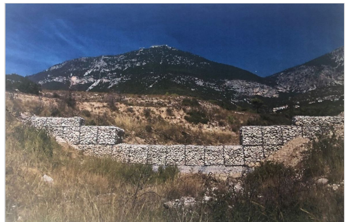
ΕΓΚΑΡΣΙΕΣ ΣΤΗΝ ΚΟΙΤΗ ΤΟΥ ΡΕΜΑΤΟΣ ΚΑΤΑΣΚΕΥΕΣ ΣΥΡΜΑΤΟΚΙΒΩΤΙΩΝ
