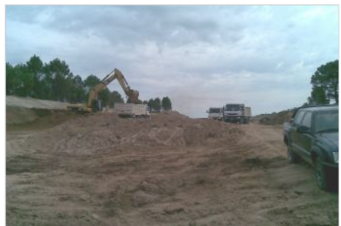
Durante la Obra
