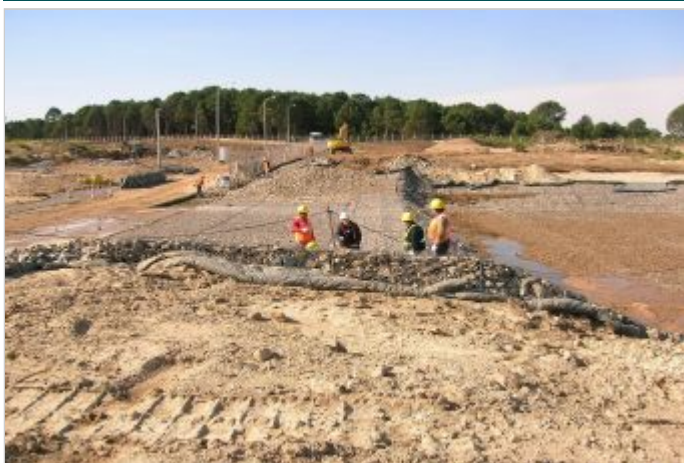
Durante la Obra
