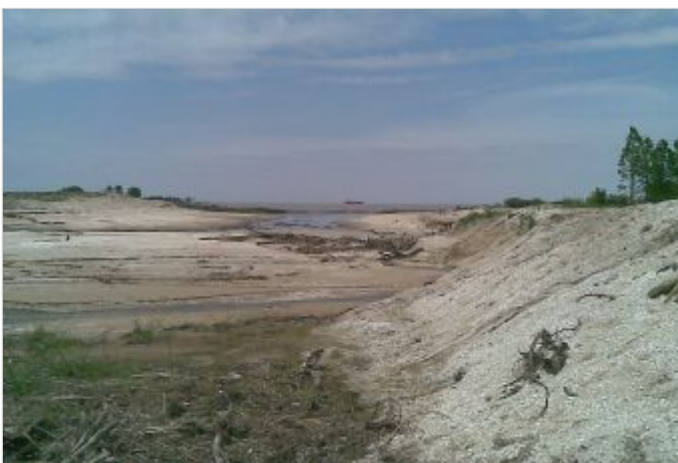
Durante la Obra
