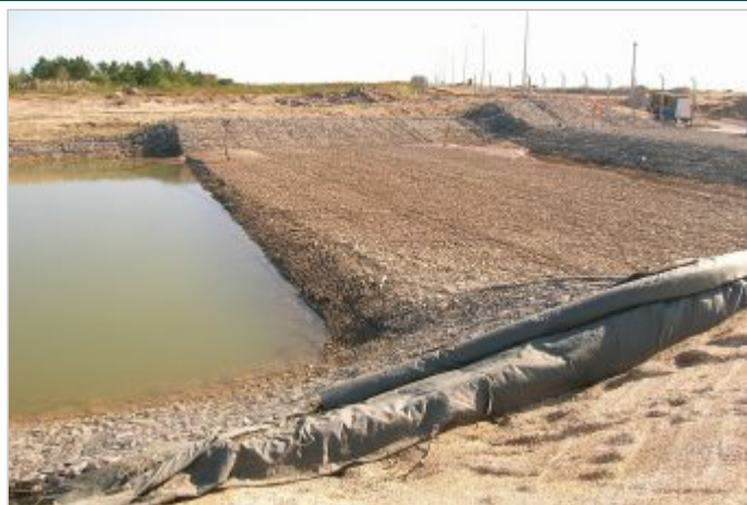
Durante la Obra
