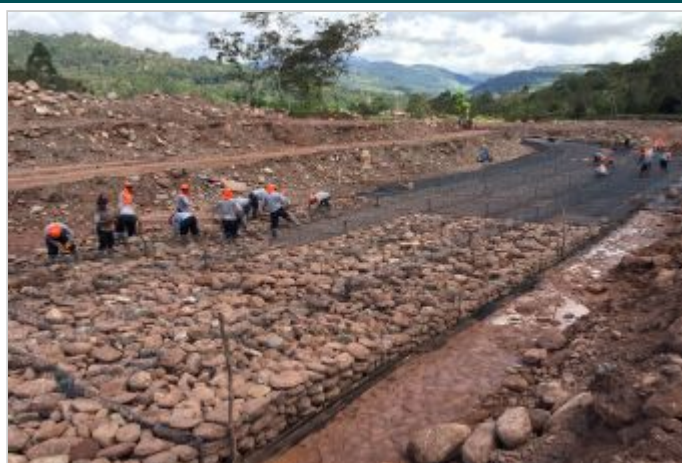
Durante la Obra
