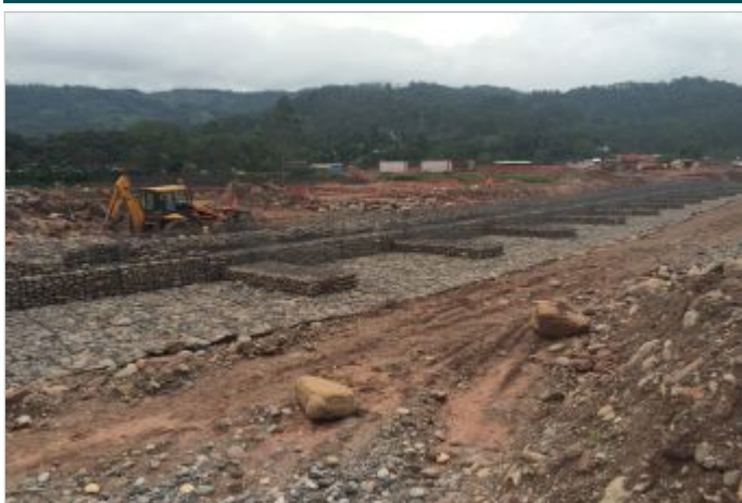
Durante la Obra
