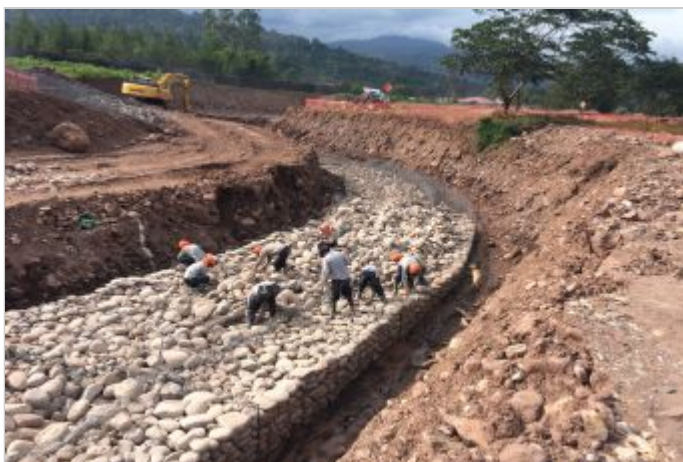
Durante la Obra
