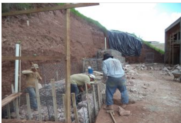
Durante a obra
