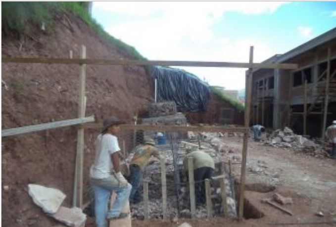
Durante a obra
