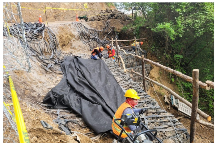
Durante la Obra
