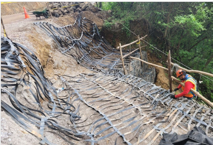
Durante la Obra
