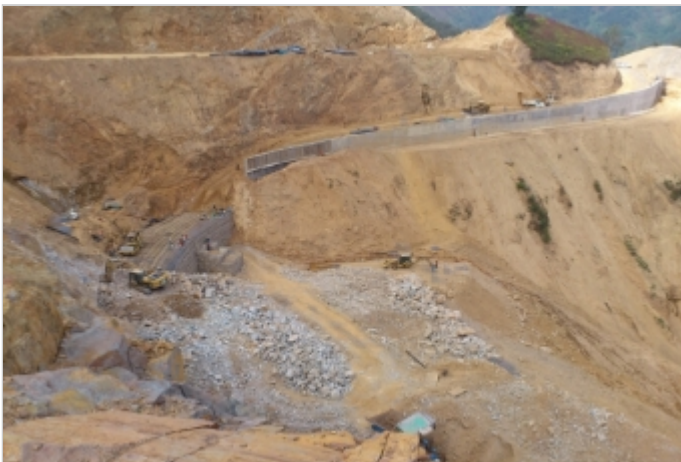
Durante la Obra
