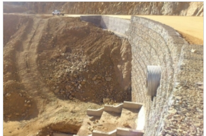
Durante la Obra
