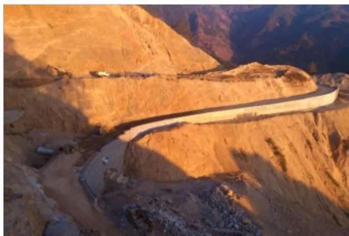
Durante la Obra
