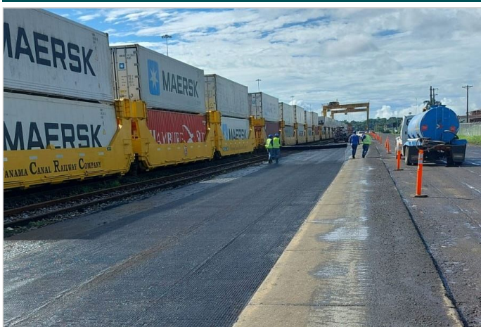
Durante la Obra
