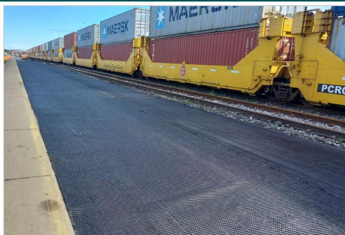
Durante la Obra
