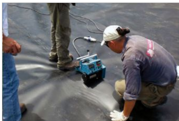
Durante la Obra
