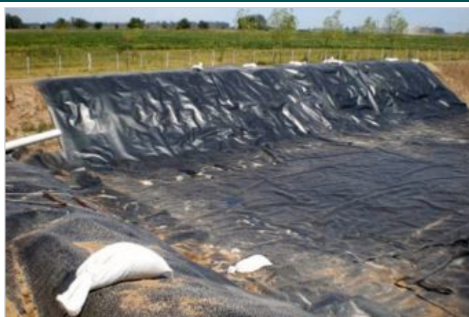
Durante la Obra
