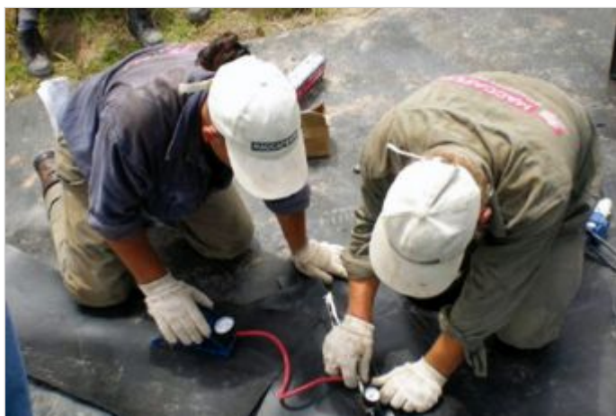
Durante la Obra
