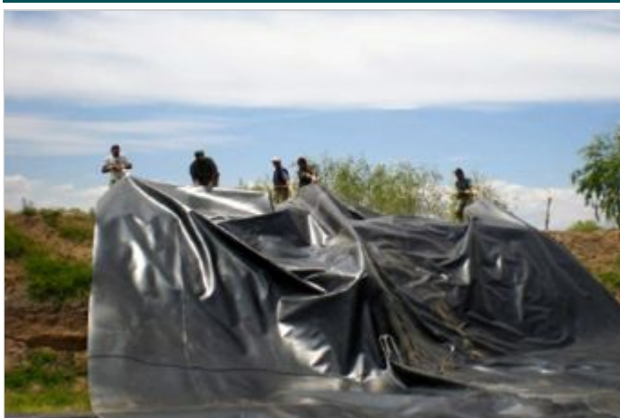
Durante la Obra
