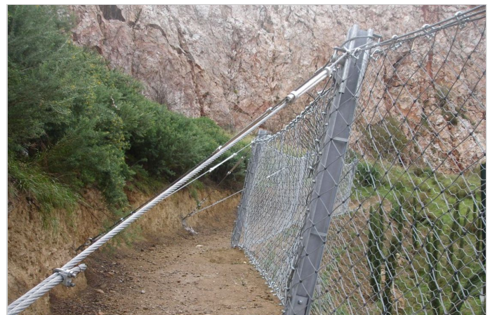
ΑΝΑΝΤΙ ΠΛΕΥΡΑ ΦΡΑΚΤΗ RMC 200/A
