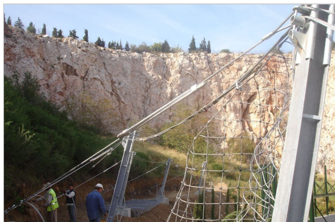
ΕΡΓΑΣΙΕΣ ΤΟΠΟΘΕΤΗΣΗΣ RMC 200A
