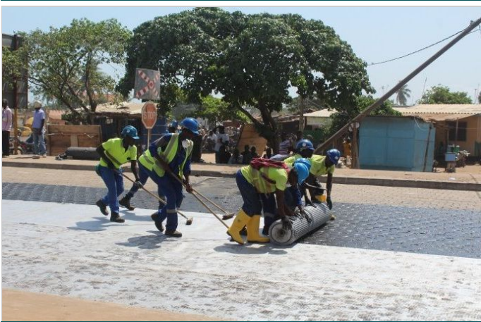
Mise en oeuvre de la géogridde
