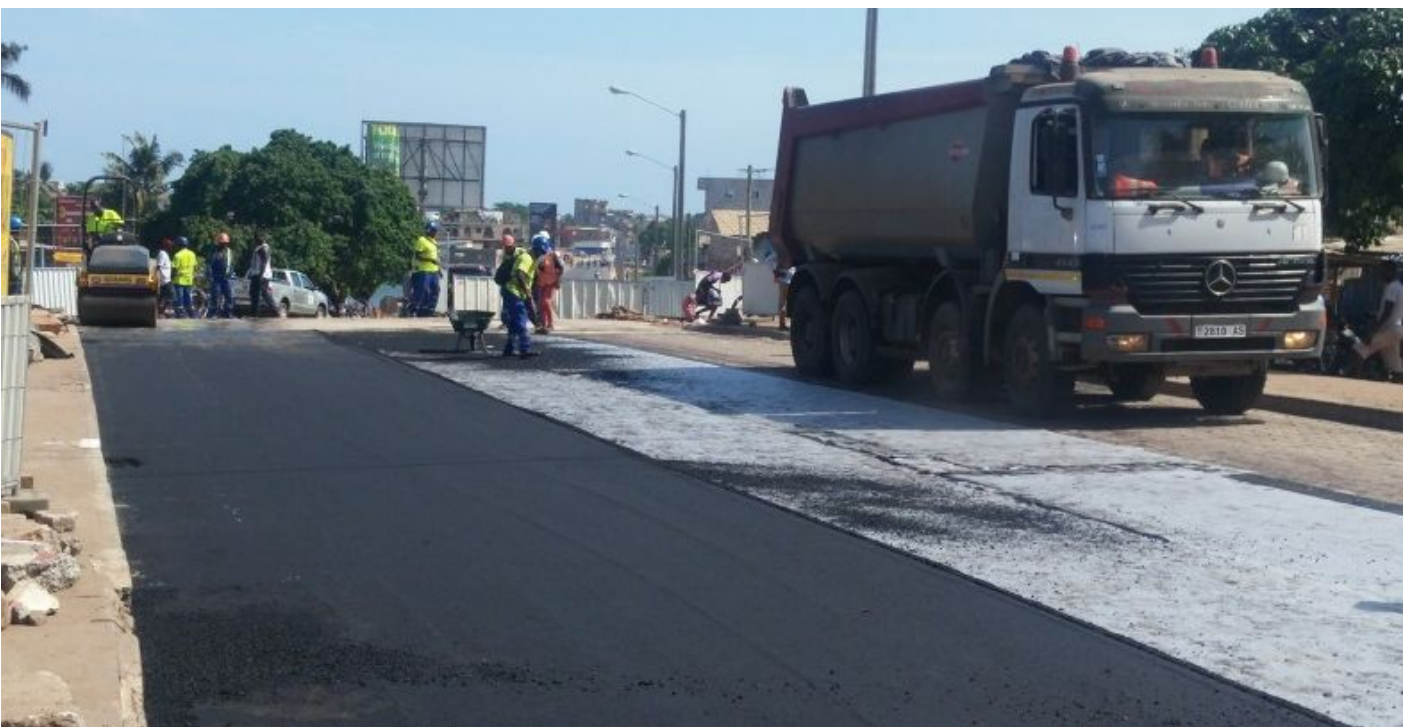
Mise en oeuvre de la géogridde
