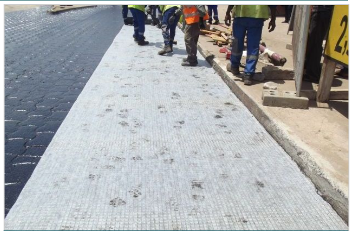
Mise en oeuvre de la géogridde
