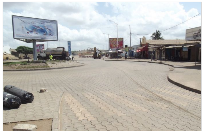
Giratoire avant travaux
