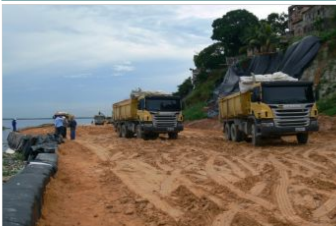
Durante la Obra
