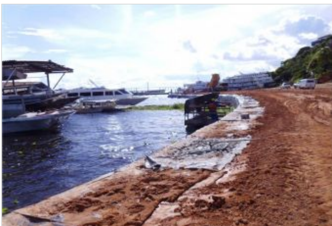
Durante la Obra
