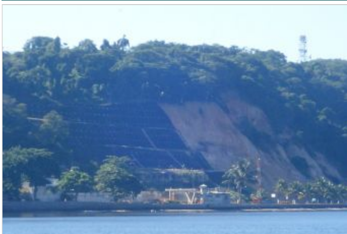
Durante la Obra
