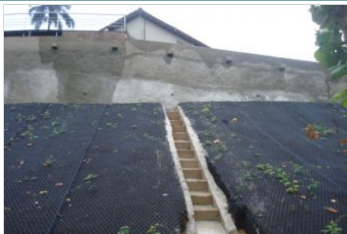
Durante la Obra
