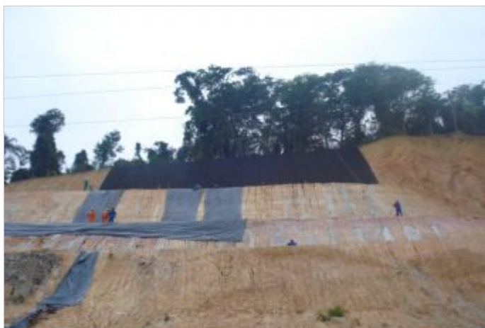
Durante la Obra
