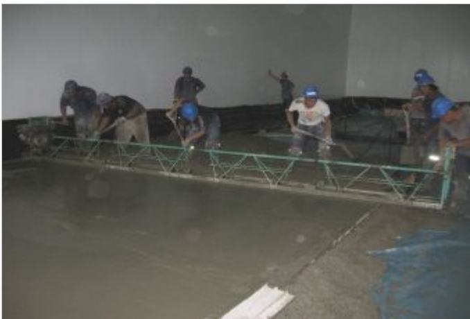
Durante la Obra
