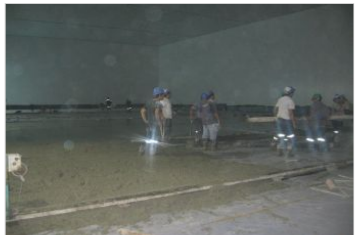
Durante la Obra
