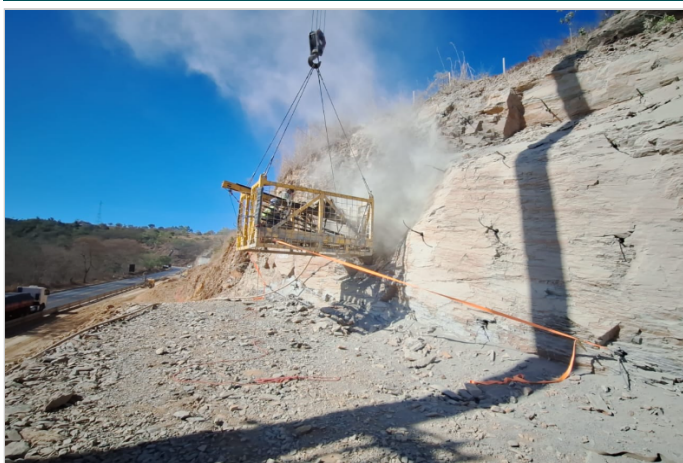
Durante a obra
