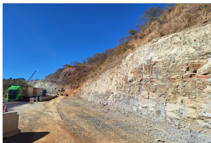
Durante a obra
