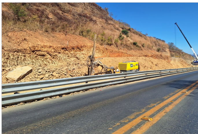
Durante a obra
