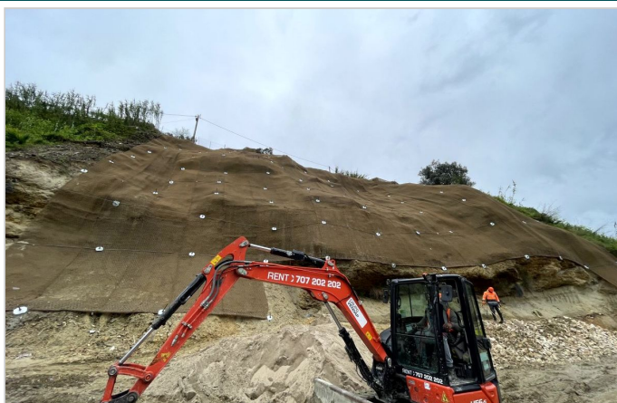
Vista desde el pie del talud del sistema de contención flexible
