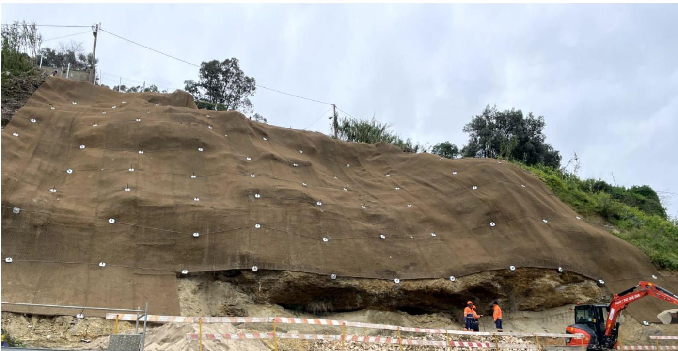
Vista general del talud estabilizado
