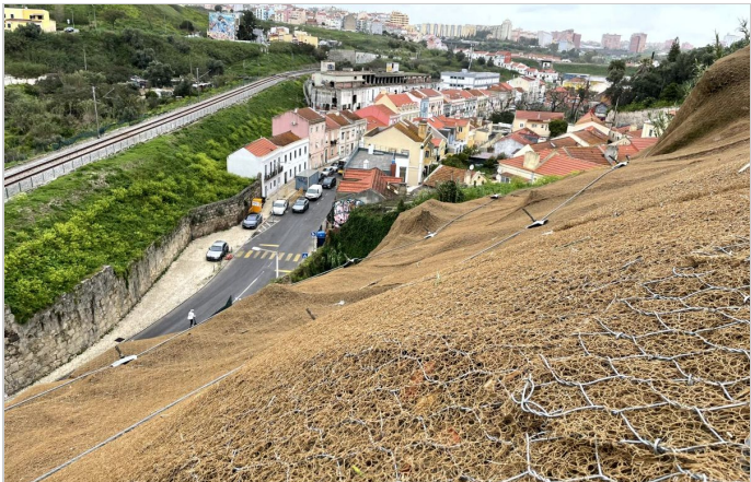
Vista de la membrana en coronación del talud
