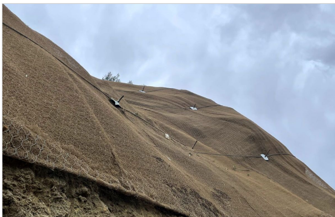
Vista del sistema flexible desde el pie del talud
