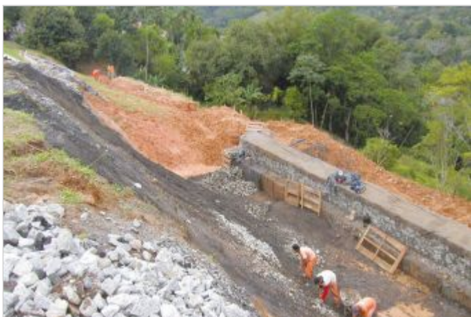
Durante a obra
