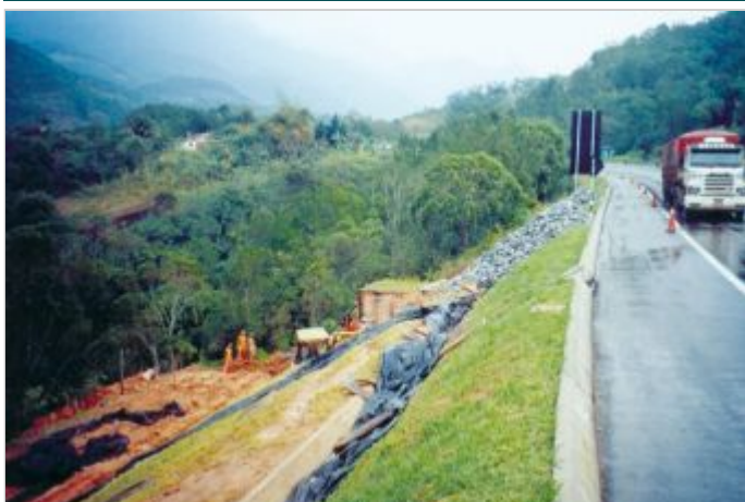
Durante a obra
