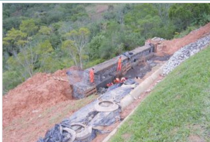
Durante a obra
