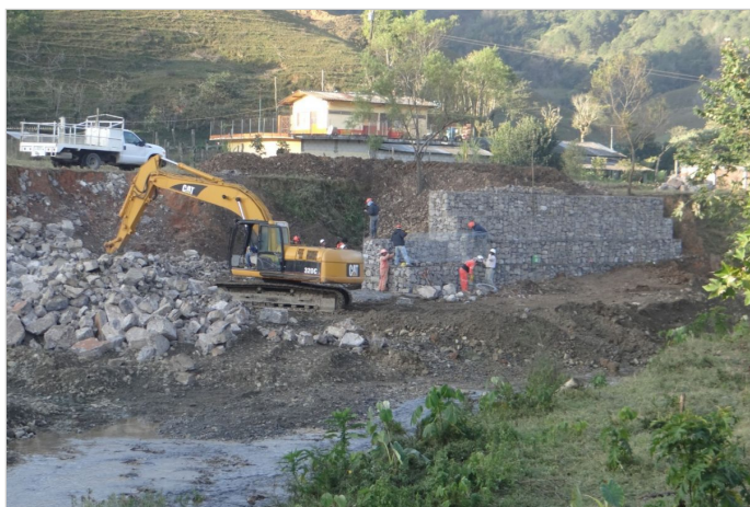
Durante a obra
