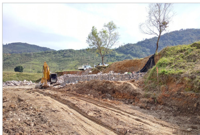
Durante a obra
