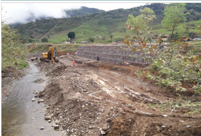
Durante a obra
