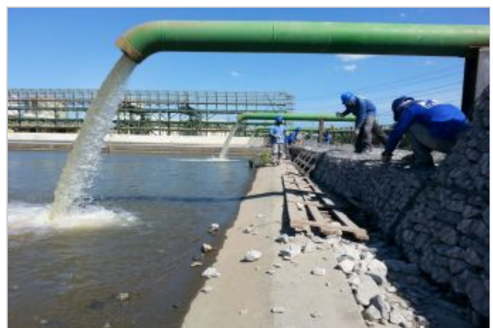
Durante la Obra
