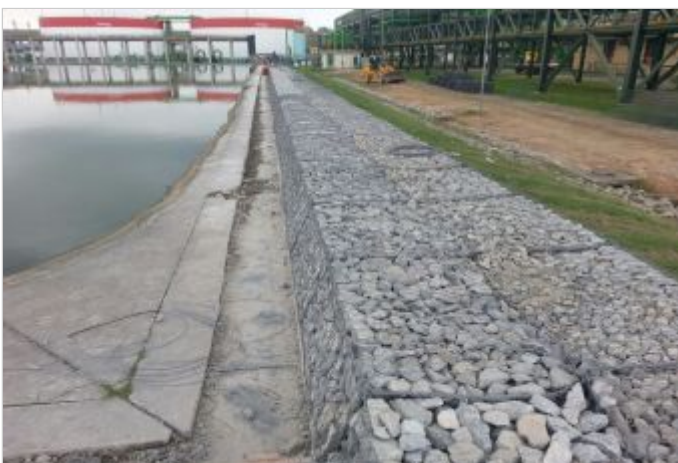
Durante la Obra
