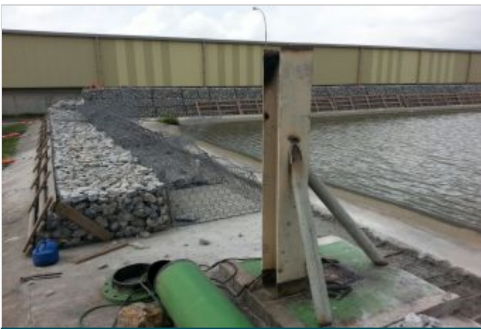
Durante la Obra
