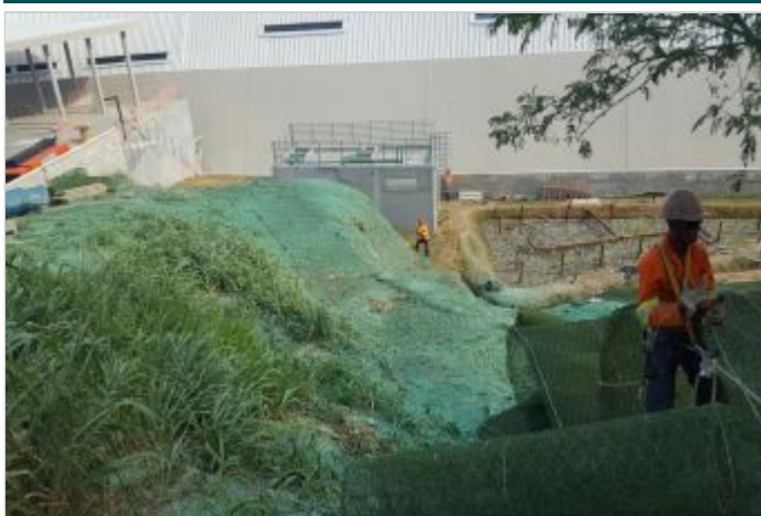
Durante a obra
