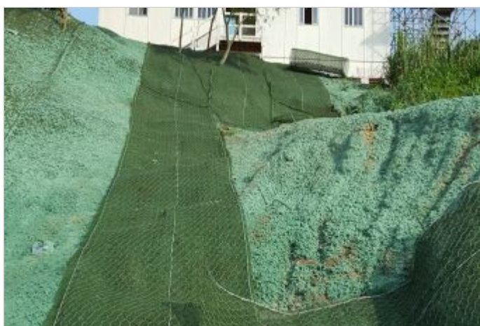
Durante a obra
