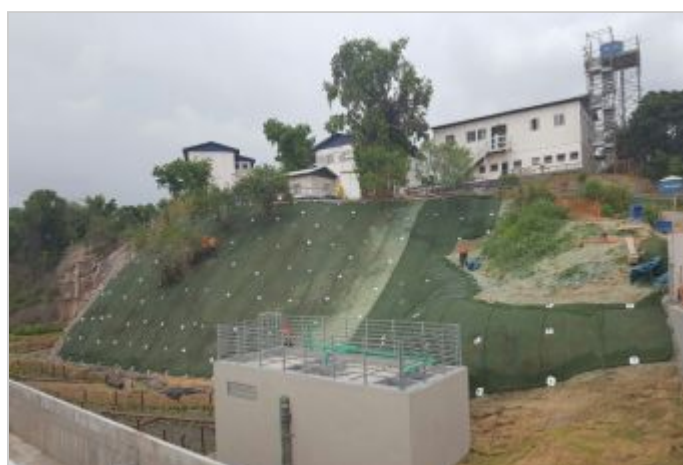
Durante a obra
