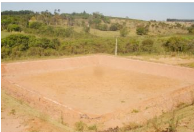
Durante la Obra
