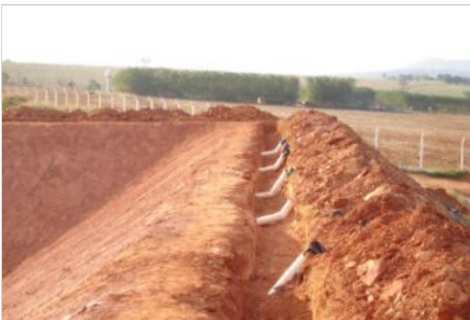
Durante la Obra
