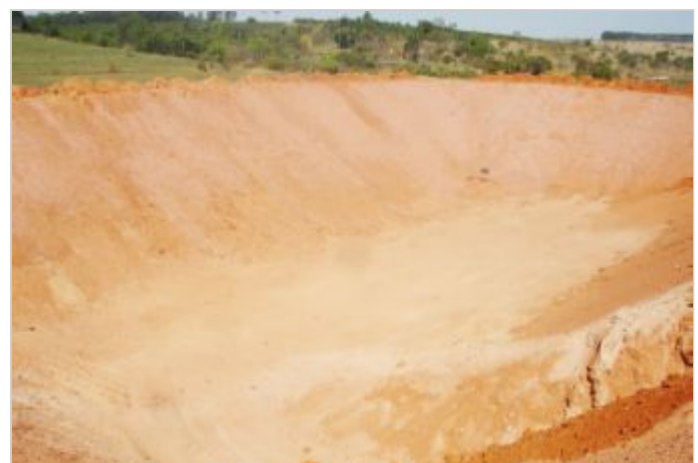
Durante la Obra
