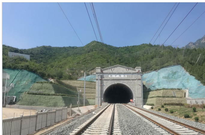
生态基材喷播完成
