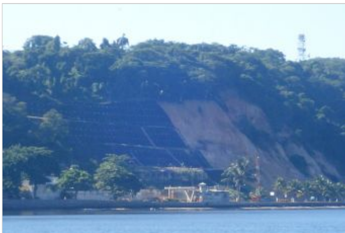
Durante a obra
