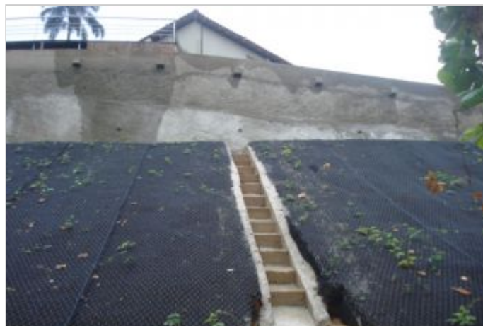
Durante a obra
