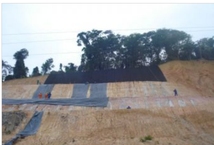
Durante a obra
