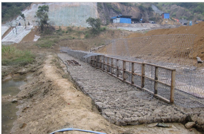
加筋格宾施工中
