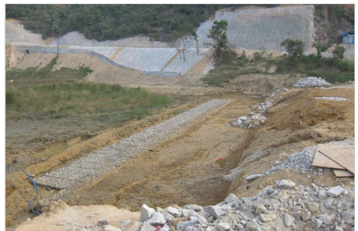
第一层加筋格宾和雷诺护垫施工
