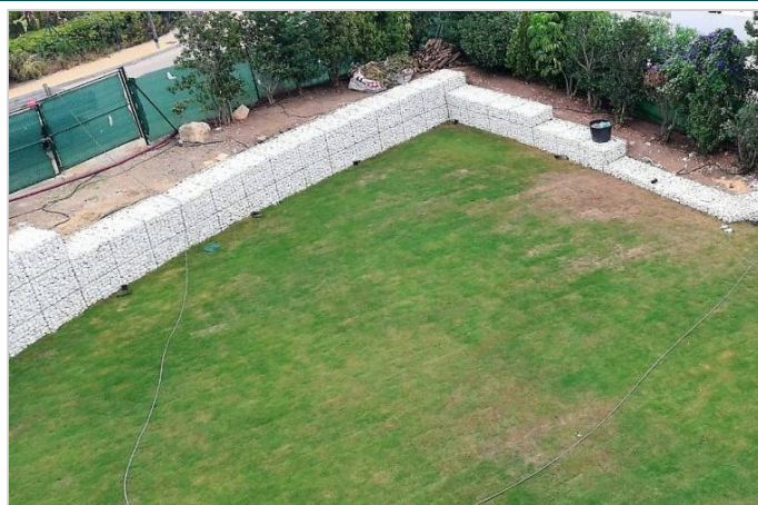
Vista aérea muro GAVIARQ
