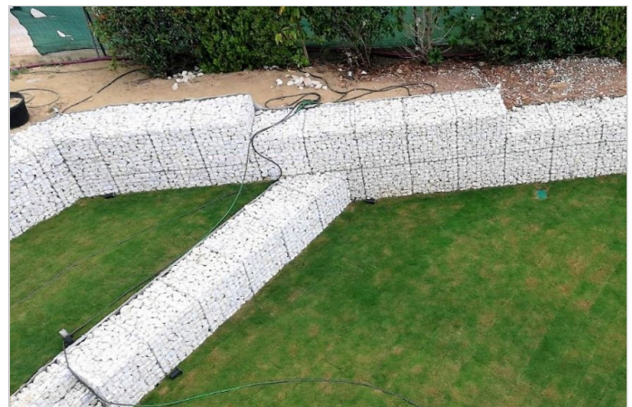
Proceso de instalación GAVIARQ y diferenciación de niveles de la parcela
