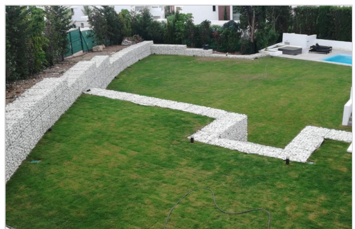
Vista muro y escaleras mediante sistema GAVIARQ
