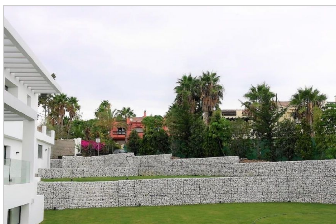
Vista doble muro GAVIARQ, permite diferenciar niveles dentro de la parcela
