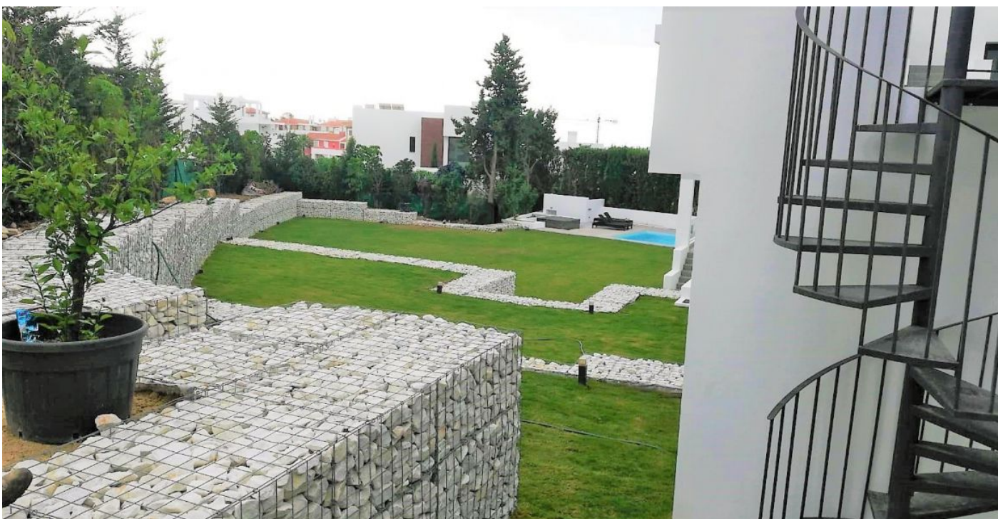
Vista general final de la obra, muro y escaleras en sistema GAVIARQ
