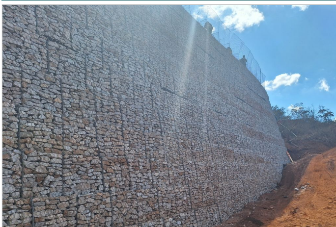
Durante a obra
