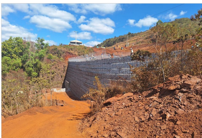
Durante a obra
