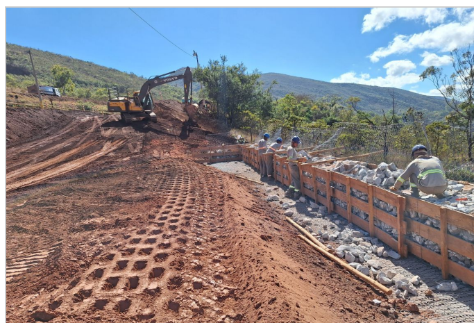
Durante a obra
