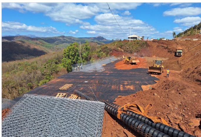
Durante a obra
