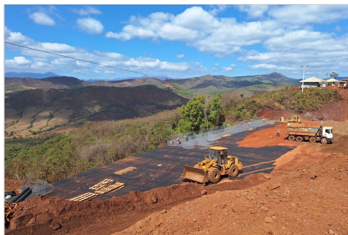
Durante a obra
