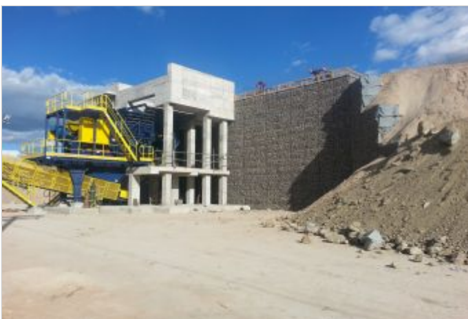
Durante a obra
