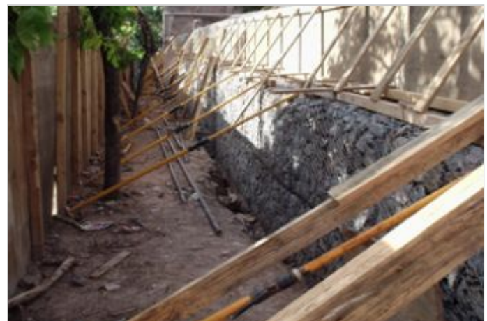
Durante la Obra
