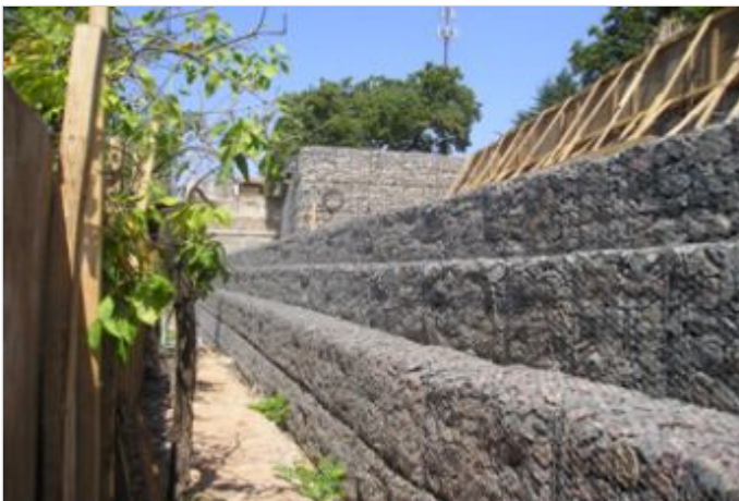
Durante la Obra
