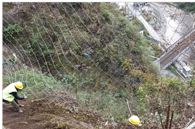
被动防护网系统施工中
