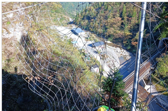
被动防护网系统施工
