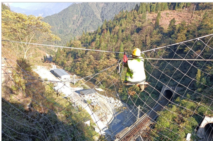
被动防护网系统施工中
