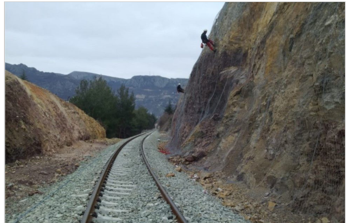
Kaya Taş Düşmesi Koruması Uygulaması
