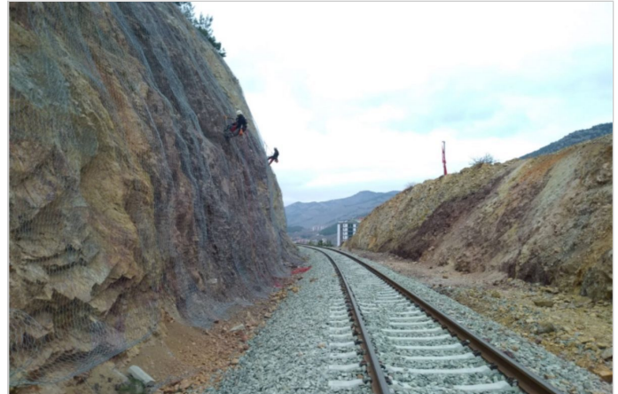
Kaya Taş Düşmesi Koruması Uygulaması
