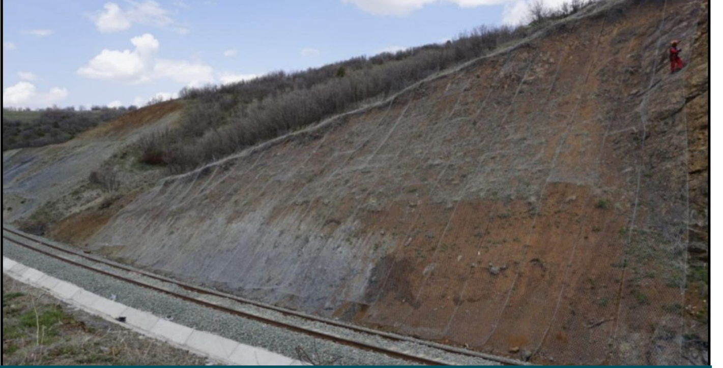
Kaya Taş Düşmesi Koruması Uygulaması
