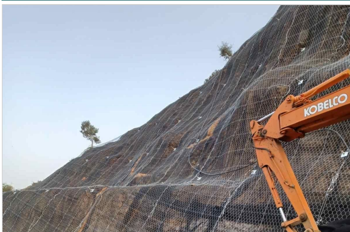
ΠΛΗΡΩΣ ΑΓΚΥΡΟΥΜΕΝΟ ΠΛΕΓΜΑ MACARMOUR 60x60 ΣΤΗ ΦΑΣΗ ΤΗΣ ΤΟΠΟΘΕΤΗΣΗΣ
