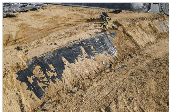
Durante la Obra
