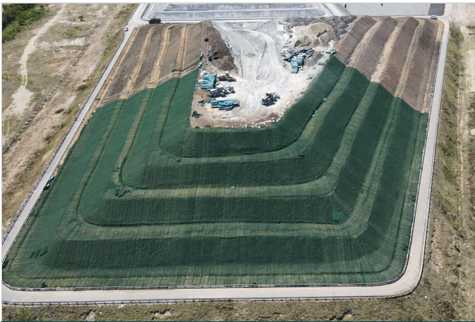
Durante la Obra
