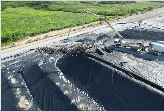
Durante la Obra
