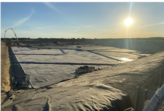
Durante la Obra
