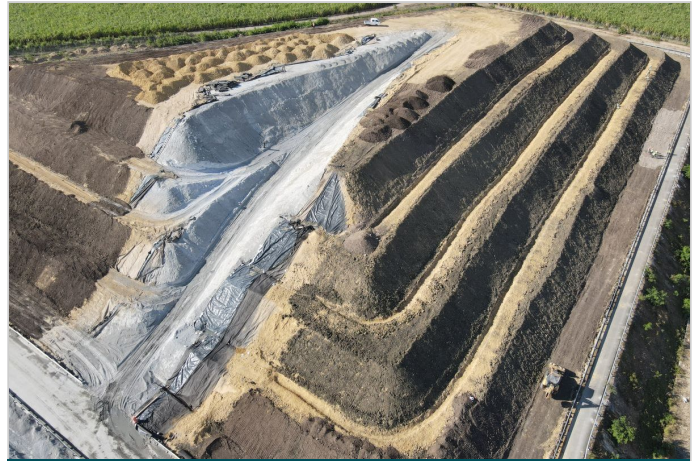
Durante la Obra
