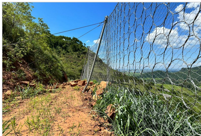
Durante a obra
