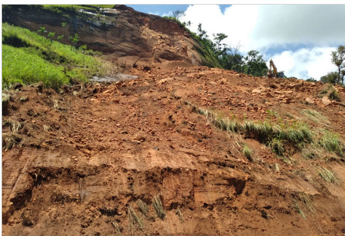
Durante a obra
