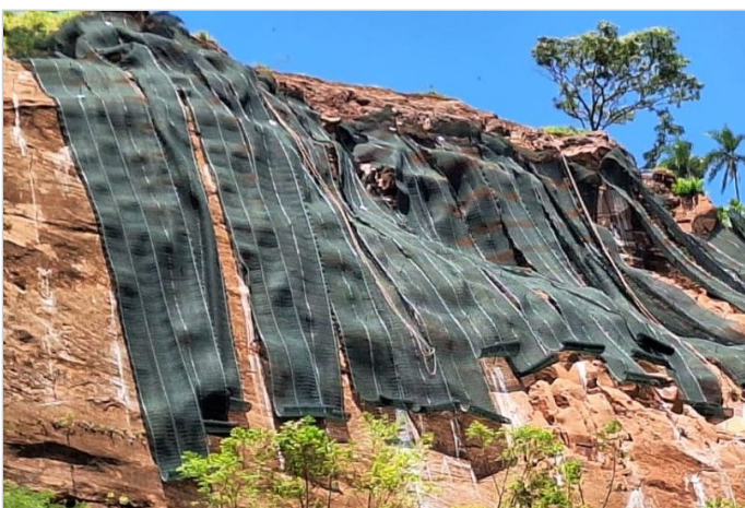
Durante a obra
