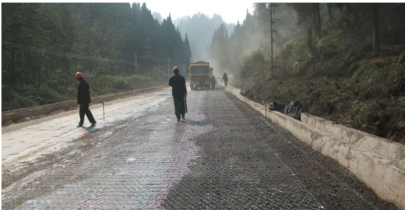
路面加筋网铺设完成
