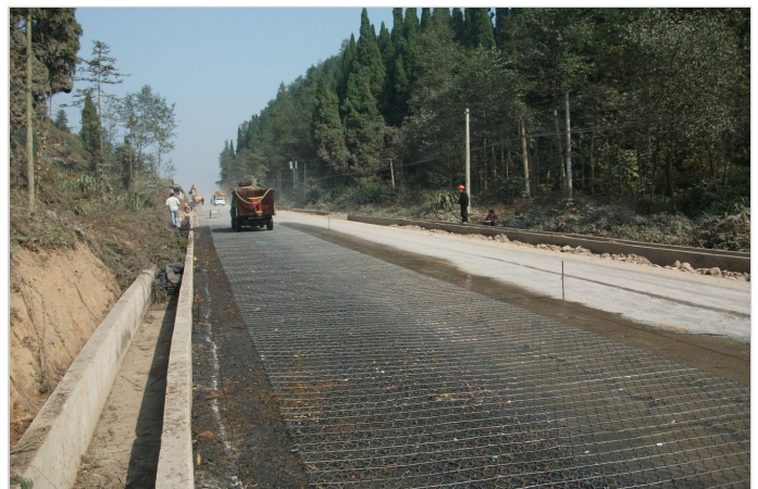
路面加筋网铺设
