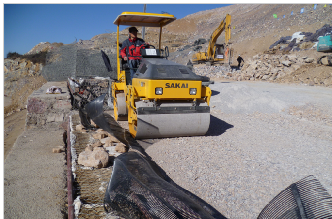
图二：项目施工中
