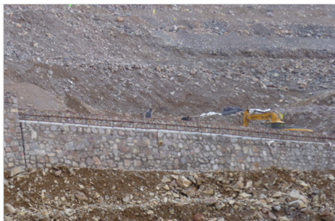
图一：项目施工前
