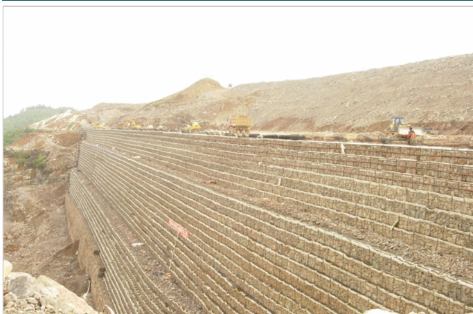
图三：项目竣工照片
