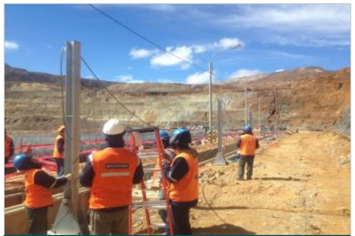
Durante la Obra
