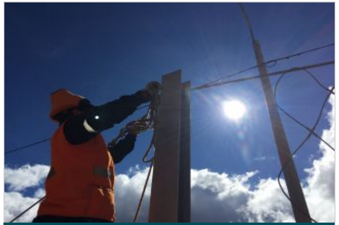
Durante la Obra
