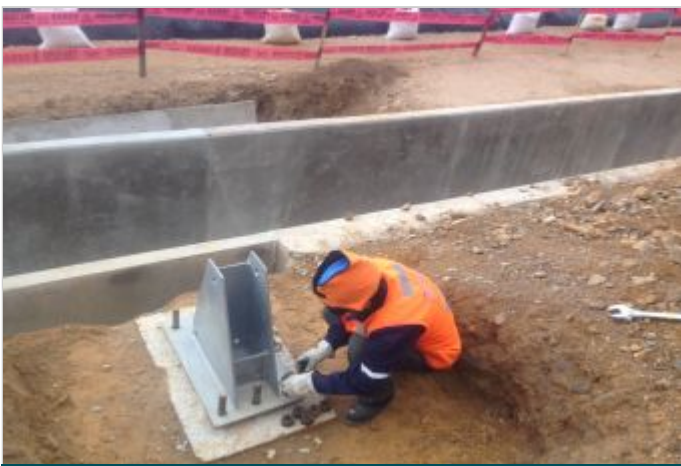
Durante la Obra
