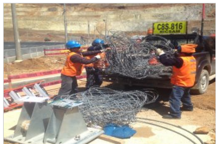
Durante la Obra
