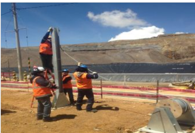
Durante la Obra
