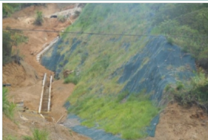
Durante a obra
