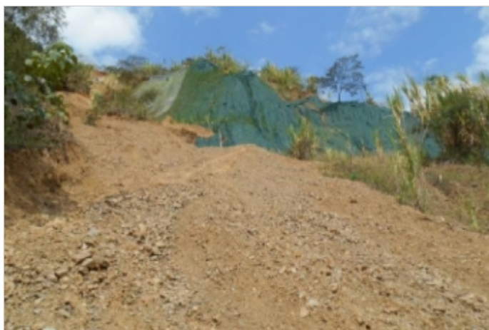
Durante a obra
