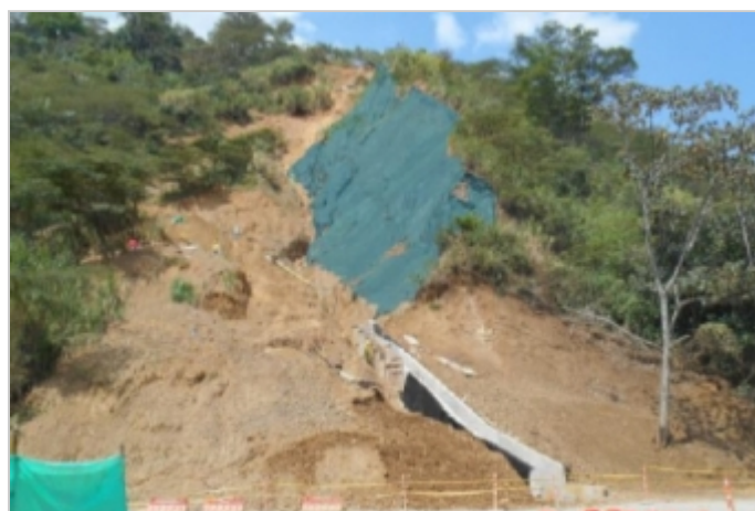
Durante a obra
