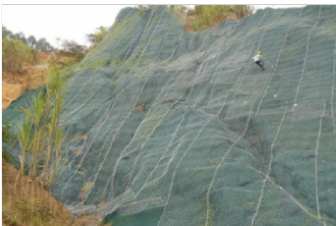
Durante a obra
