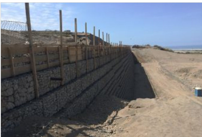
Durante la Obra
