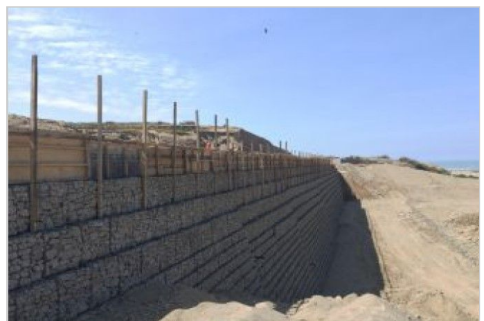
Durante la Obra
