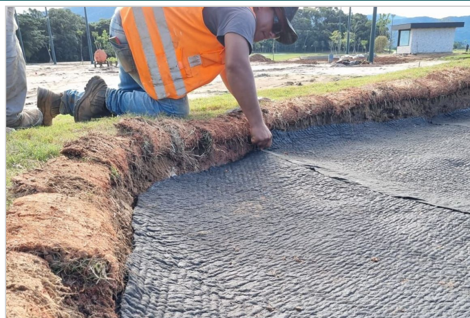
Durante a obra
