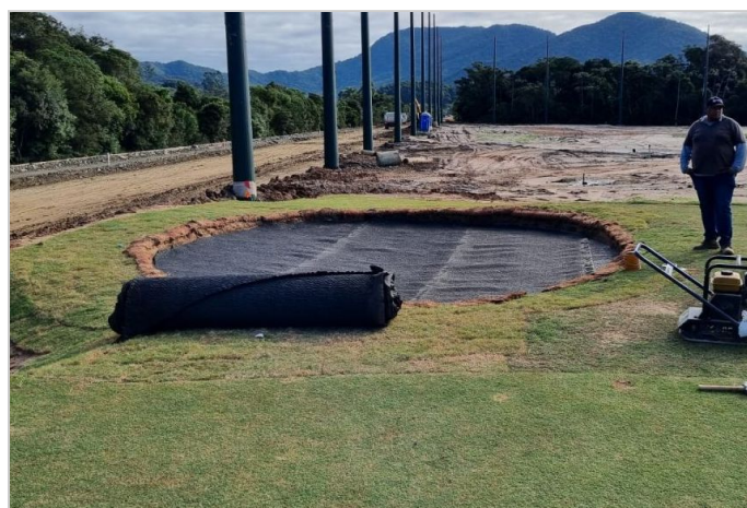
Durante a obra
