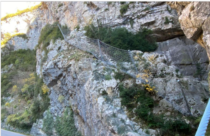
Barrera instalada en berma
