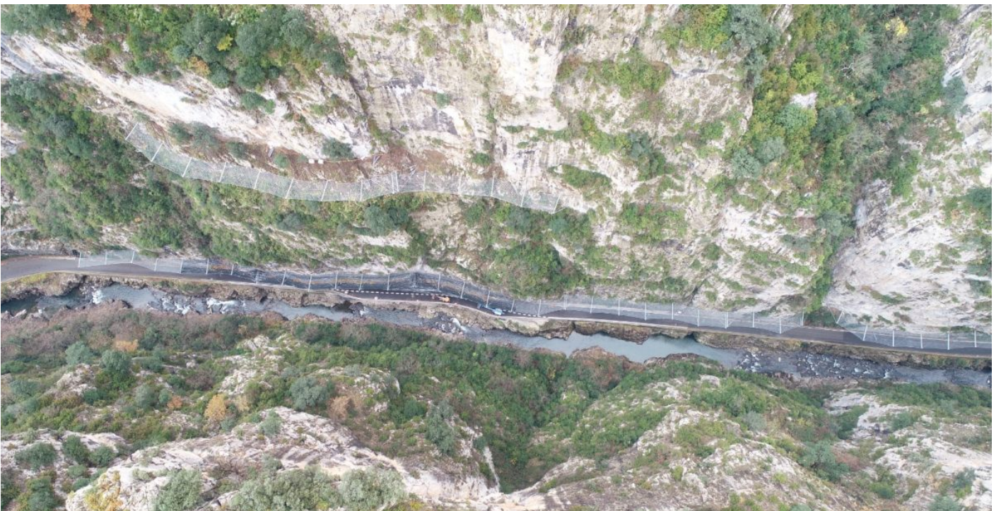
Vista área de la carretera
