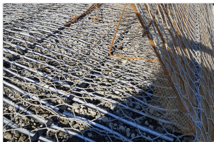
Mise en oeuvre Terramesh vert et géogrilles ParaDrain & ParaGrid
