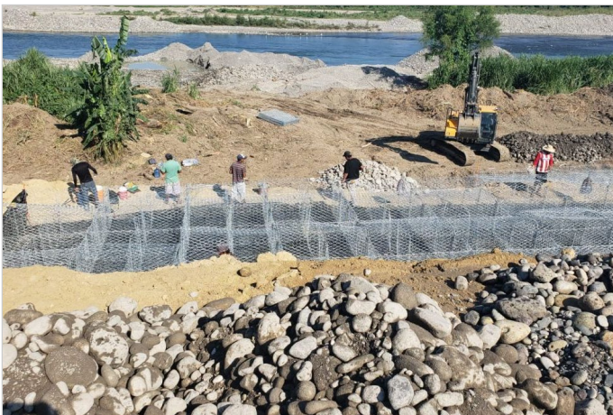
Durante la Obra
