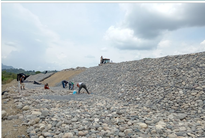
Durante la Obra
