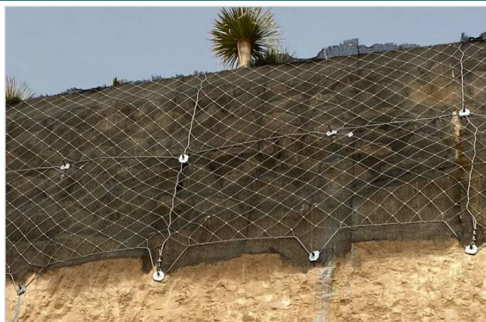
Detalle anclajes parte inferior
