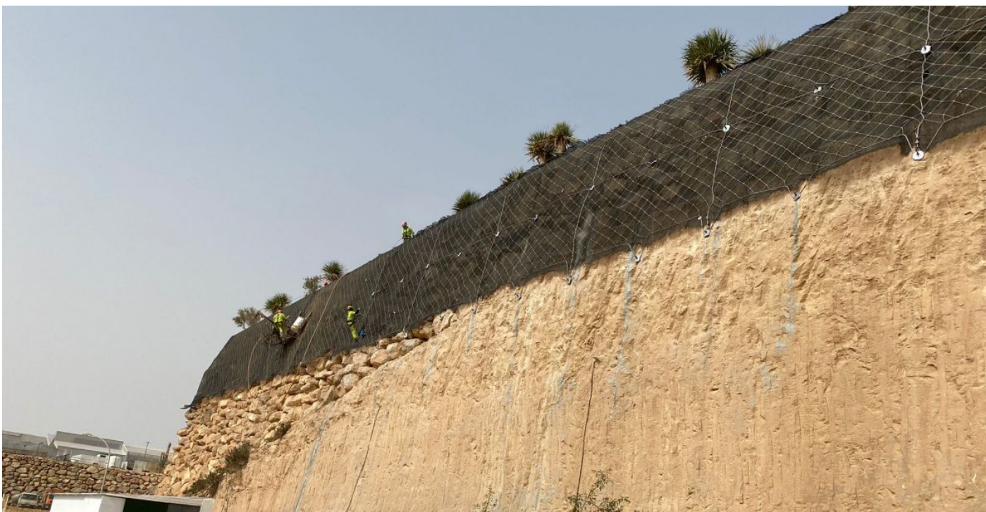
Sostenimiento mediante Red de Cable + MacMat
