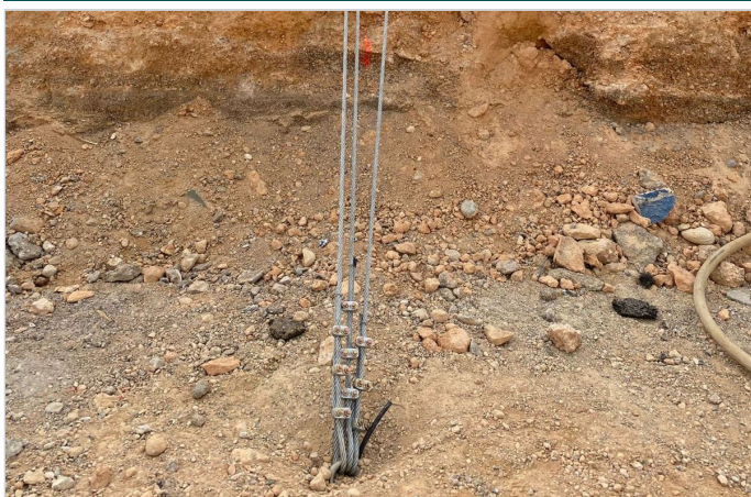
Detalle anclaje por la parte superior
