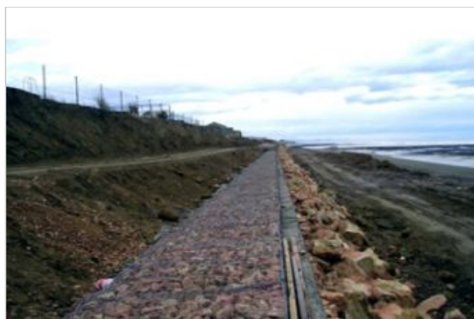
Durante a obra
