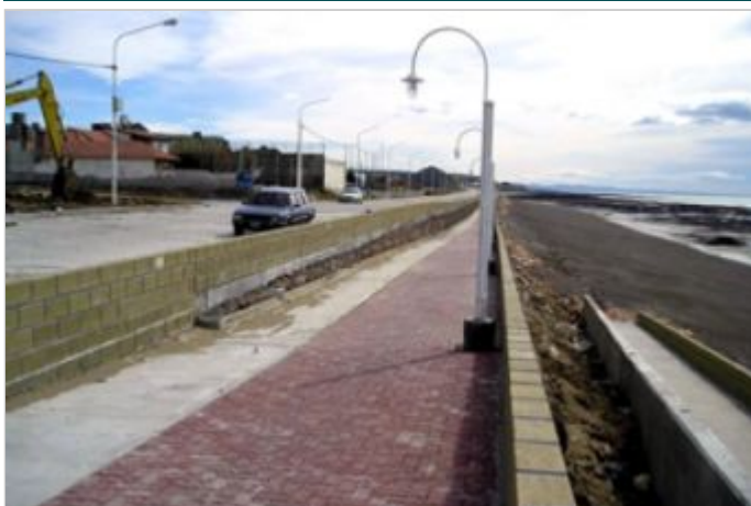
Durante a obra
