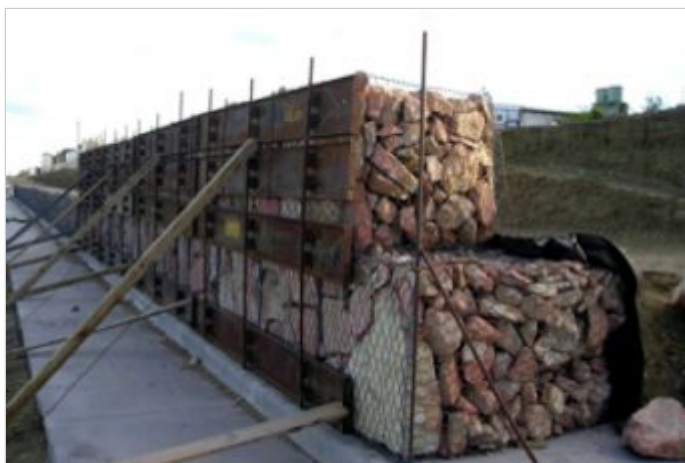
Durante a obra
