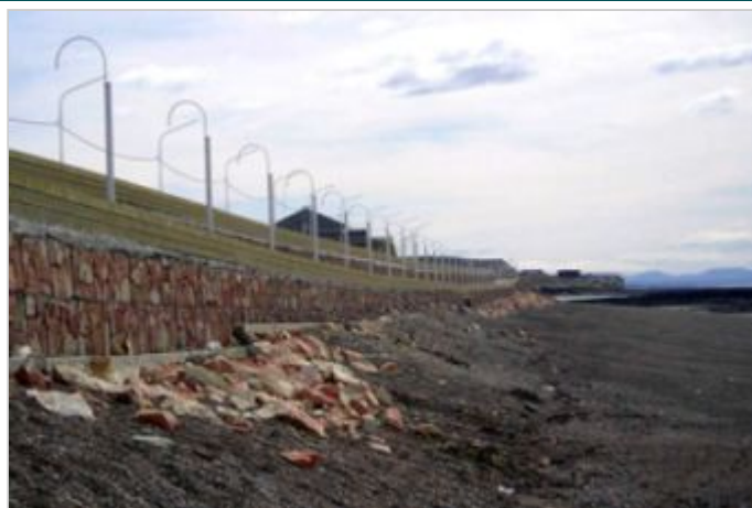
Durante a obra
