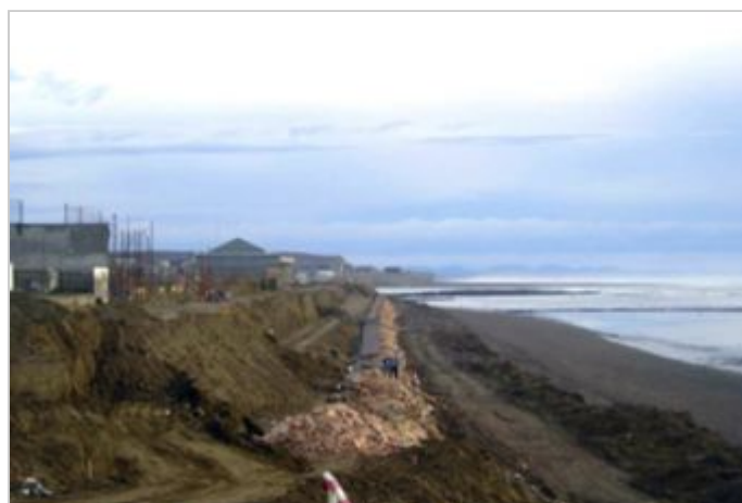
Durante a obra
