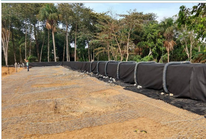
Durante a obra
