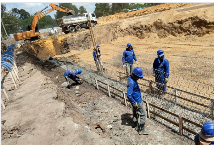
Durante a obra
