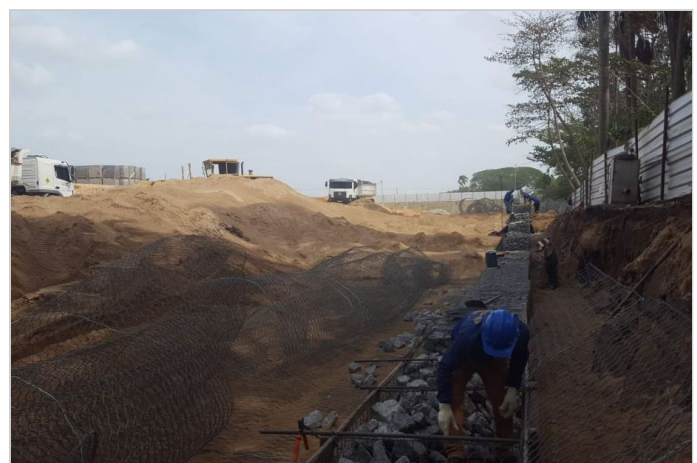
Durante a obra
