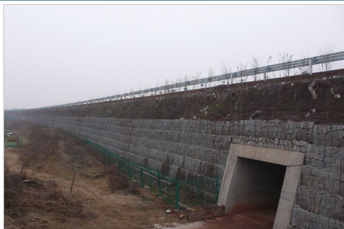
挡墙主体施工完成
