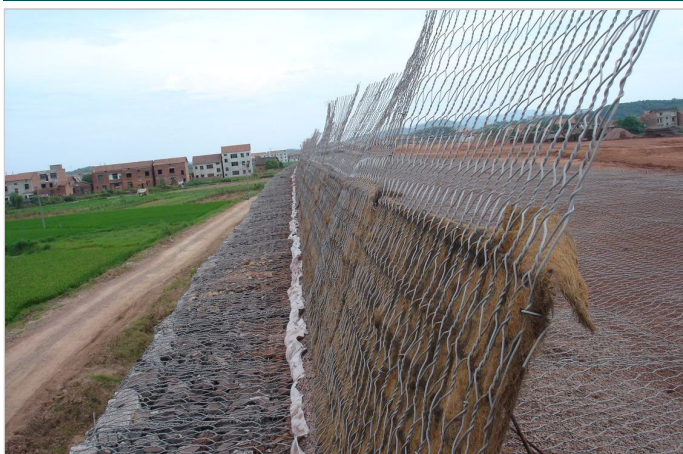
绿色加筋格宾施工中
