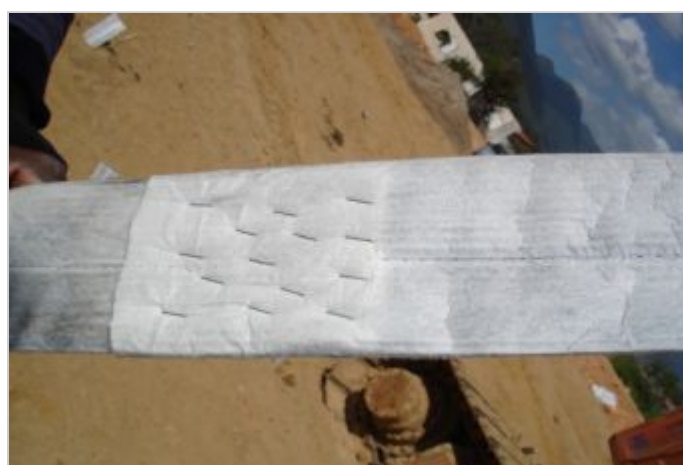
Durante a obra
