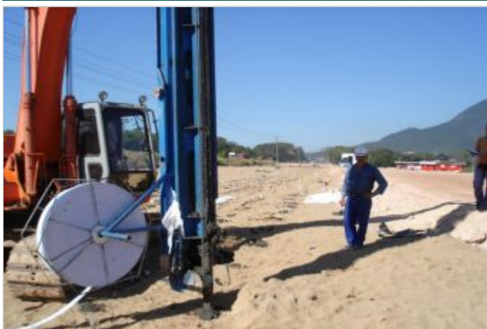
Durante a obra
