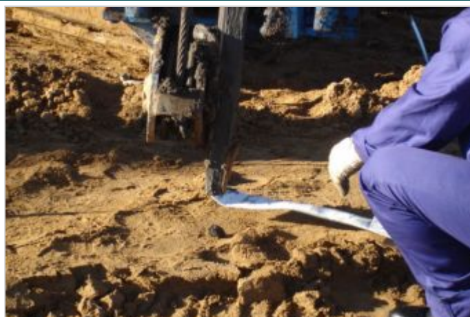
Durante a obra
